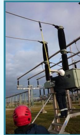
**Besonderheit :** Aufgabenstellung ist die Messung der Leiterseiltemperatur unter IR-Temperaturmessung unter Beachtung der Luft / Kriechstrecken bei 110 kV, inklusive DC Versorgung und Datenspeicher.
