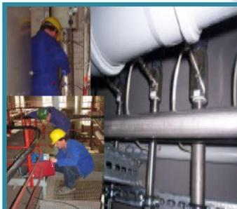
Inbetriebnahmen von Druckluft- / Stickstoff-Messstellen, Durchflussmessstellen für Flüssigkeiten, Stromversorgungen, Meteorologie und Prozessmesstechnik.
